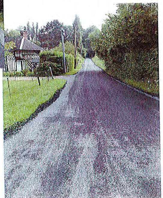
Rue de la Maladrerie
